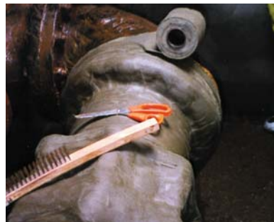
Aplicado sobre superficies con escasa preparación superficial (SP2-3).
