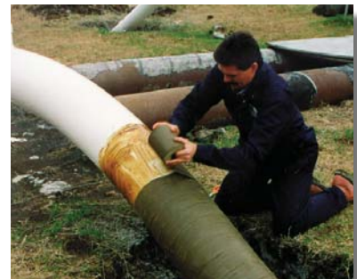
Tuberías enterradas o aéreas, bridas y válvulas. Cumple con Estándar AWWA C217.
