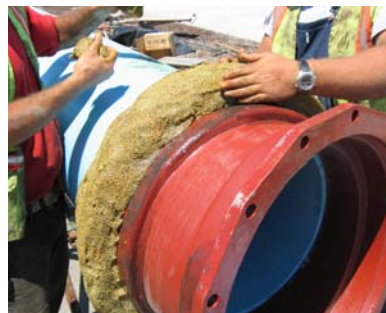
Preparación superficial mínima (SSPC SP 2-3).
