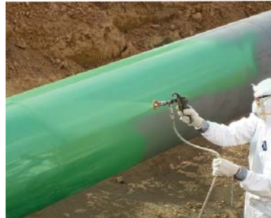
Alto espesor (hasta 70 mils en una capa).
